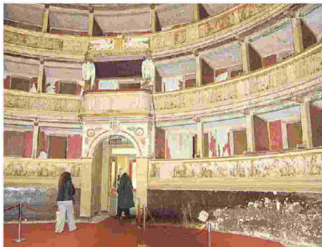
Lo stato del teatro prima della certosina ristrutturazione
